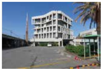
倒壊寸前の宇土市役所
